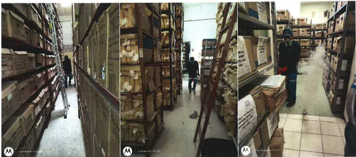
Fumigación en 2 sur 304 y ala Quirófano. 30 de junio de 2023
