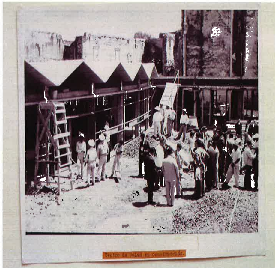
Foto del Archivo Histórico, Proceso de construcción del Centro de Salud de Atlixco, año 1963
